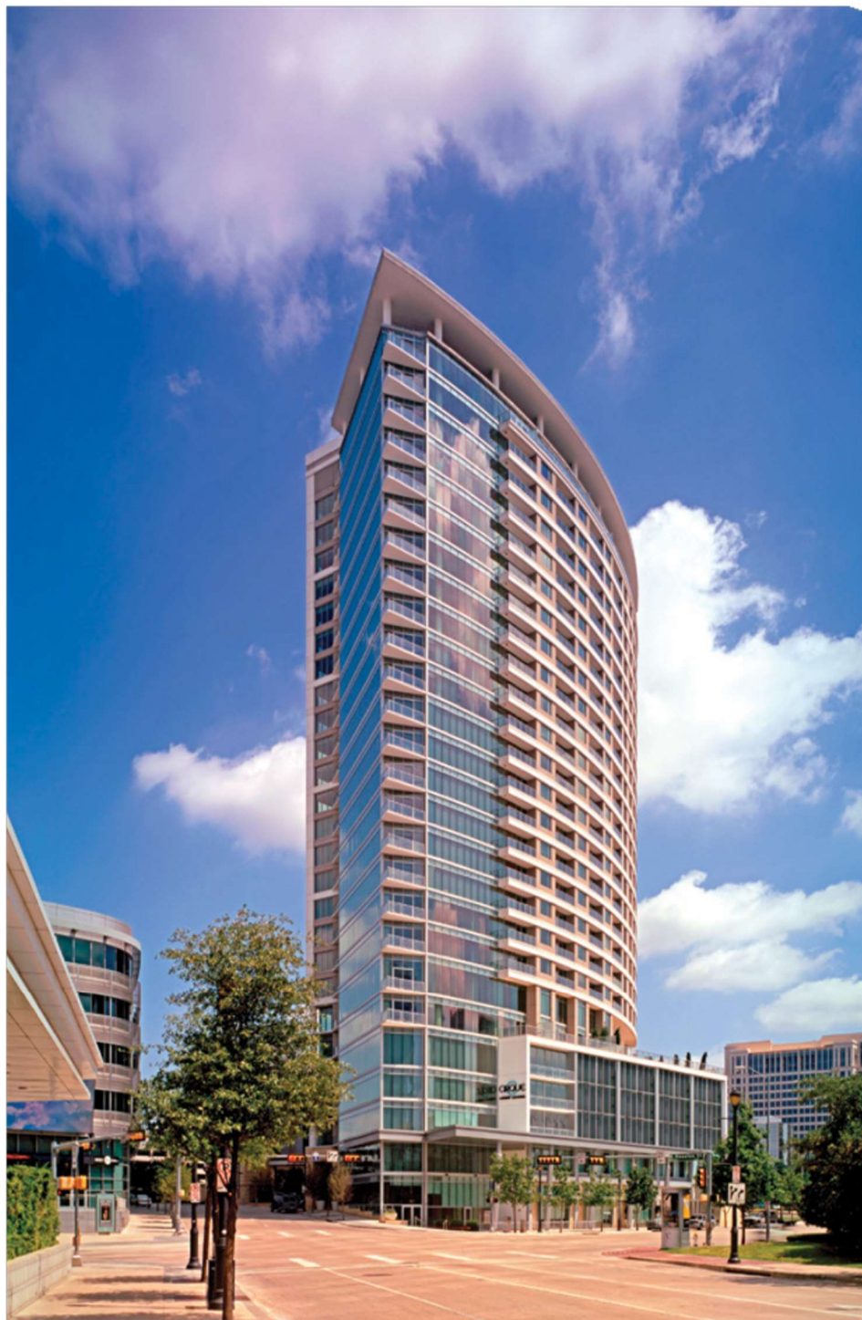
Cirque, una reluciente torre de apartamentos de lujo de 28 pisos en Dallas, fue diseñada con vidrio Solarban® 70 debido a su excelente rendimiento de control solar y transparencia.
